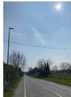
Figura 11 Illuminazione Via Torino
