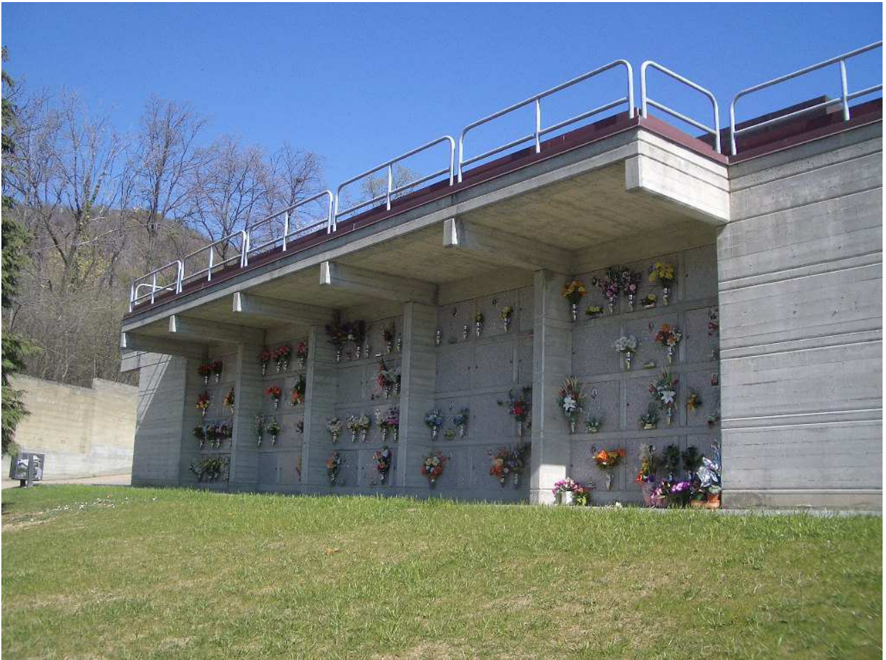
FOTO 18 – CAMPO VI – BLOCCO 11 - LOCULI
