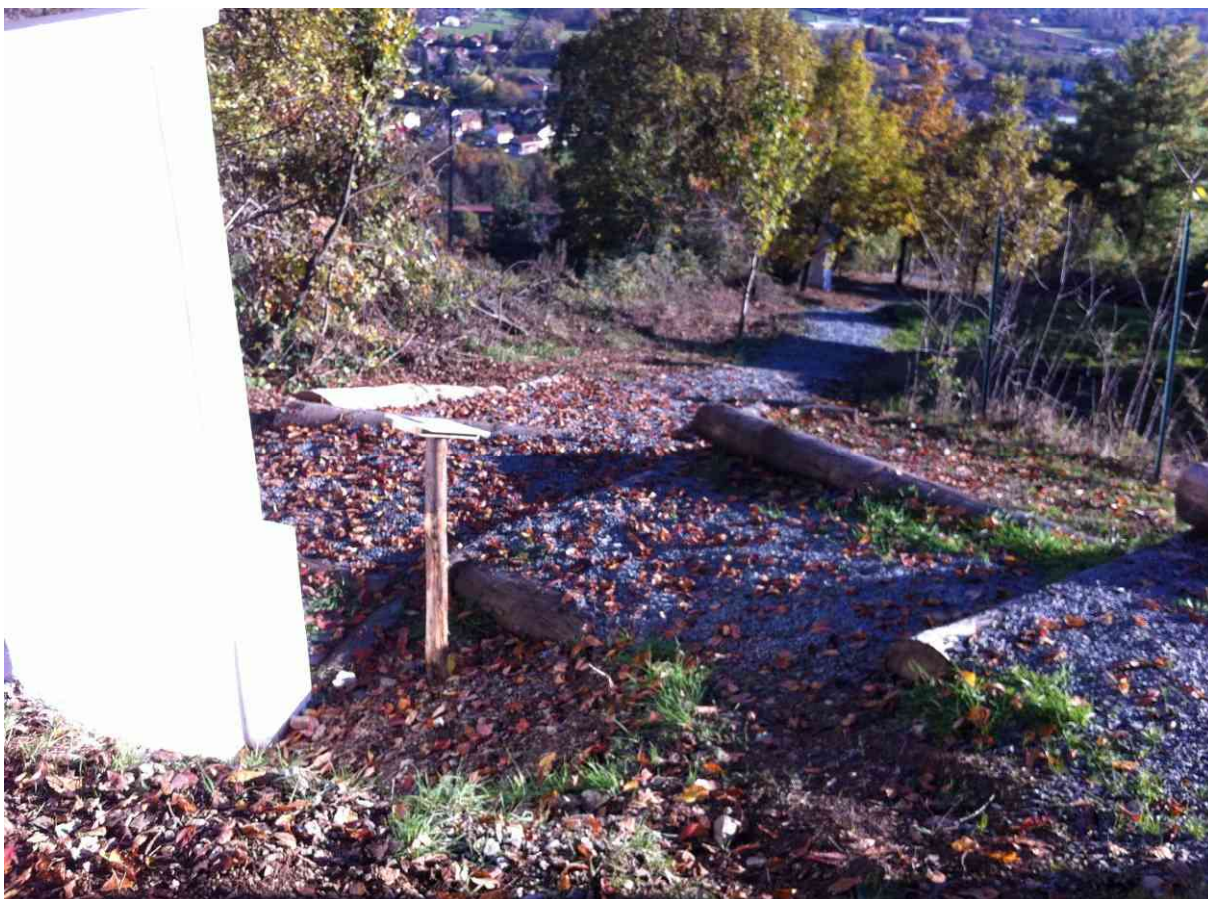
Via Crucis – Da pilone stazione 7 a scendere - Dopo i lavori
