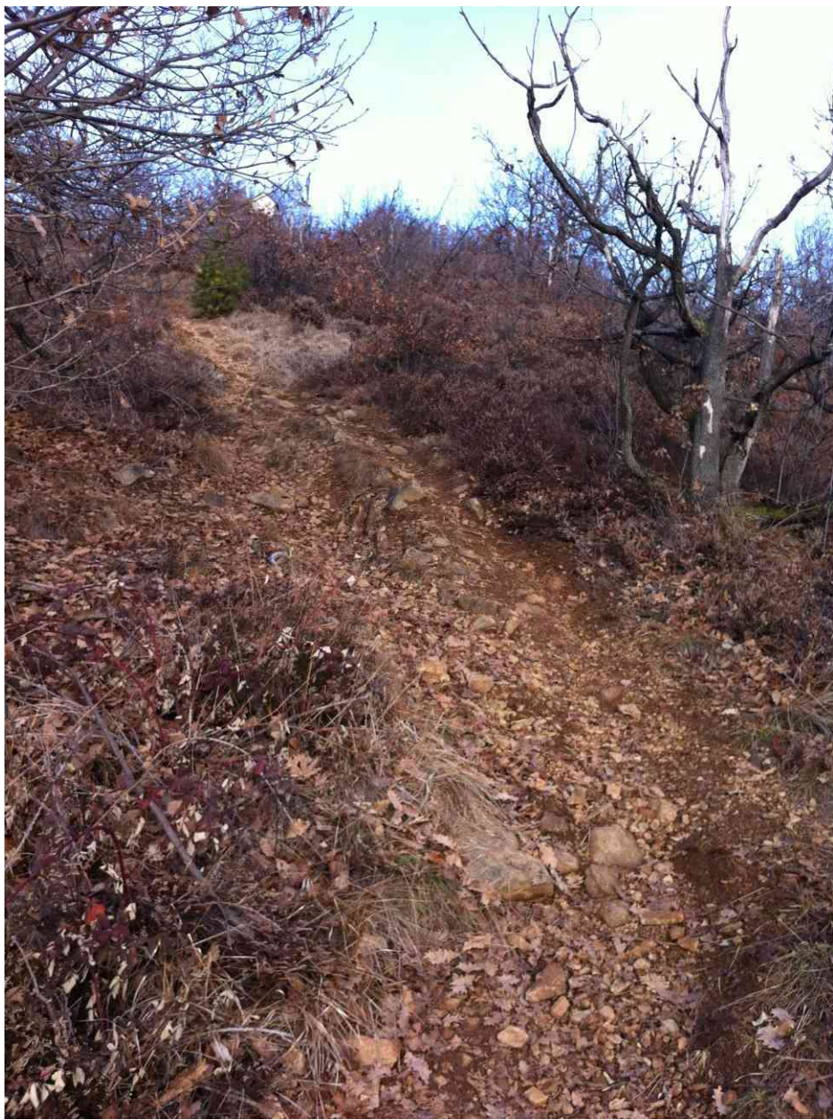
Via Crucis – Sentiero dopo Cappelletta – Prima dei lavori
