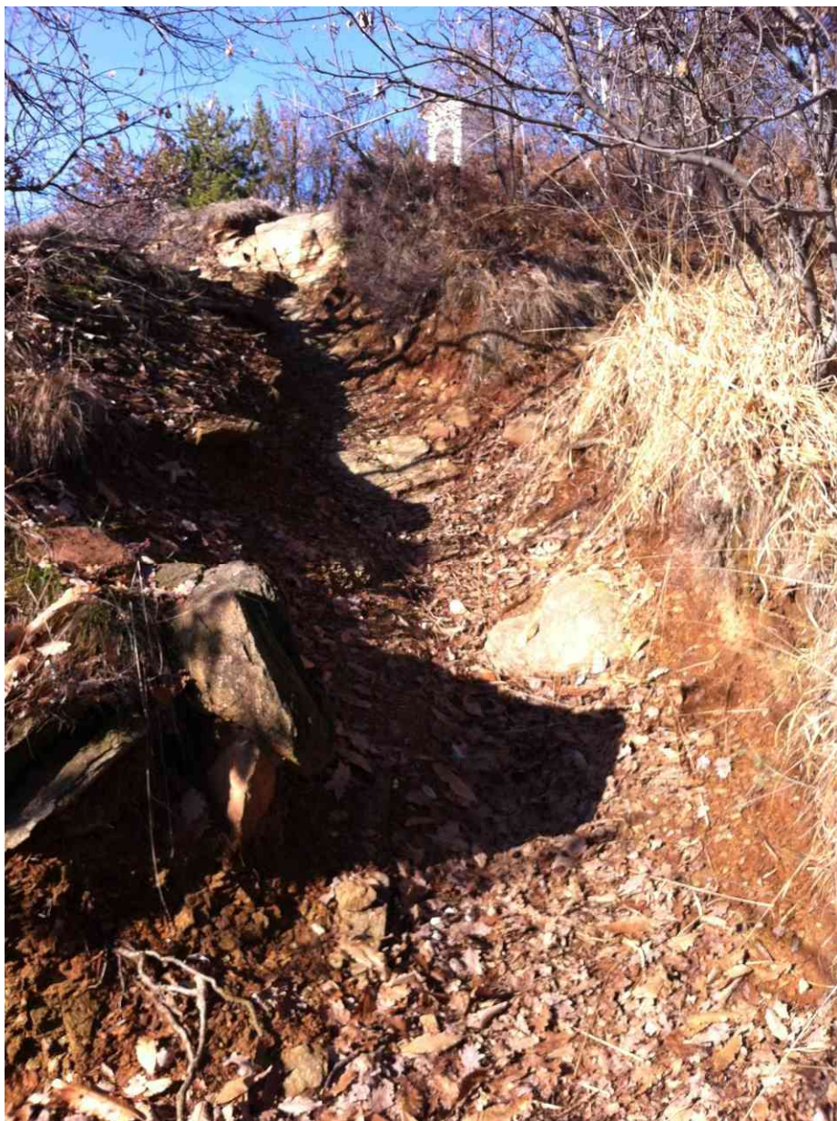
Via Crucis – Verso pilone stazione 8 a salire - Prima dei lavori
