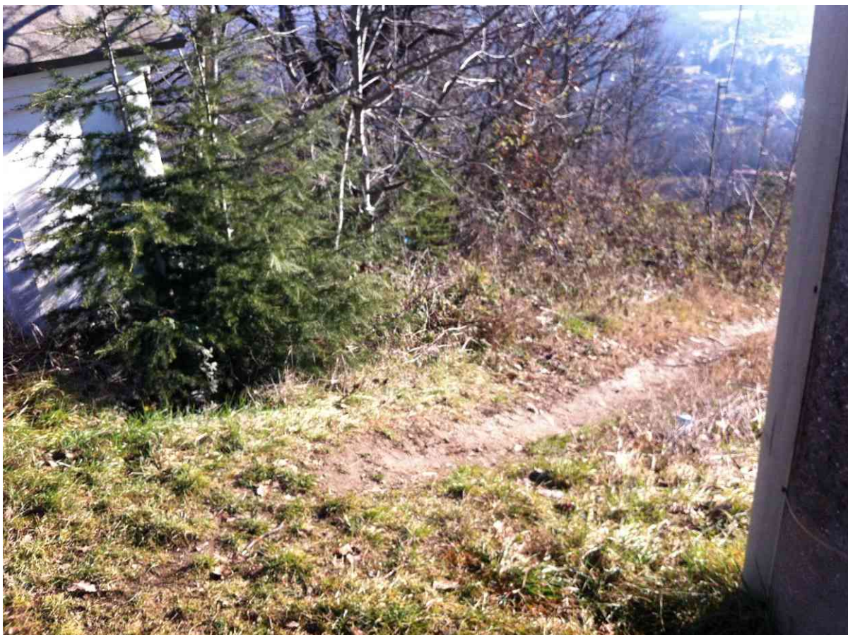
Via Crucis – Da pilone stazione 7 a scendere - Prima dei lavori
