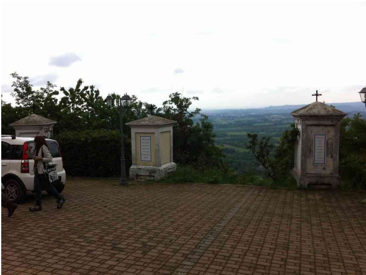
Piazzale Santuario Santa Maria – Vista verso valle – Prima dei lavori
