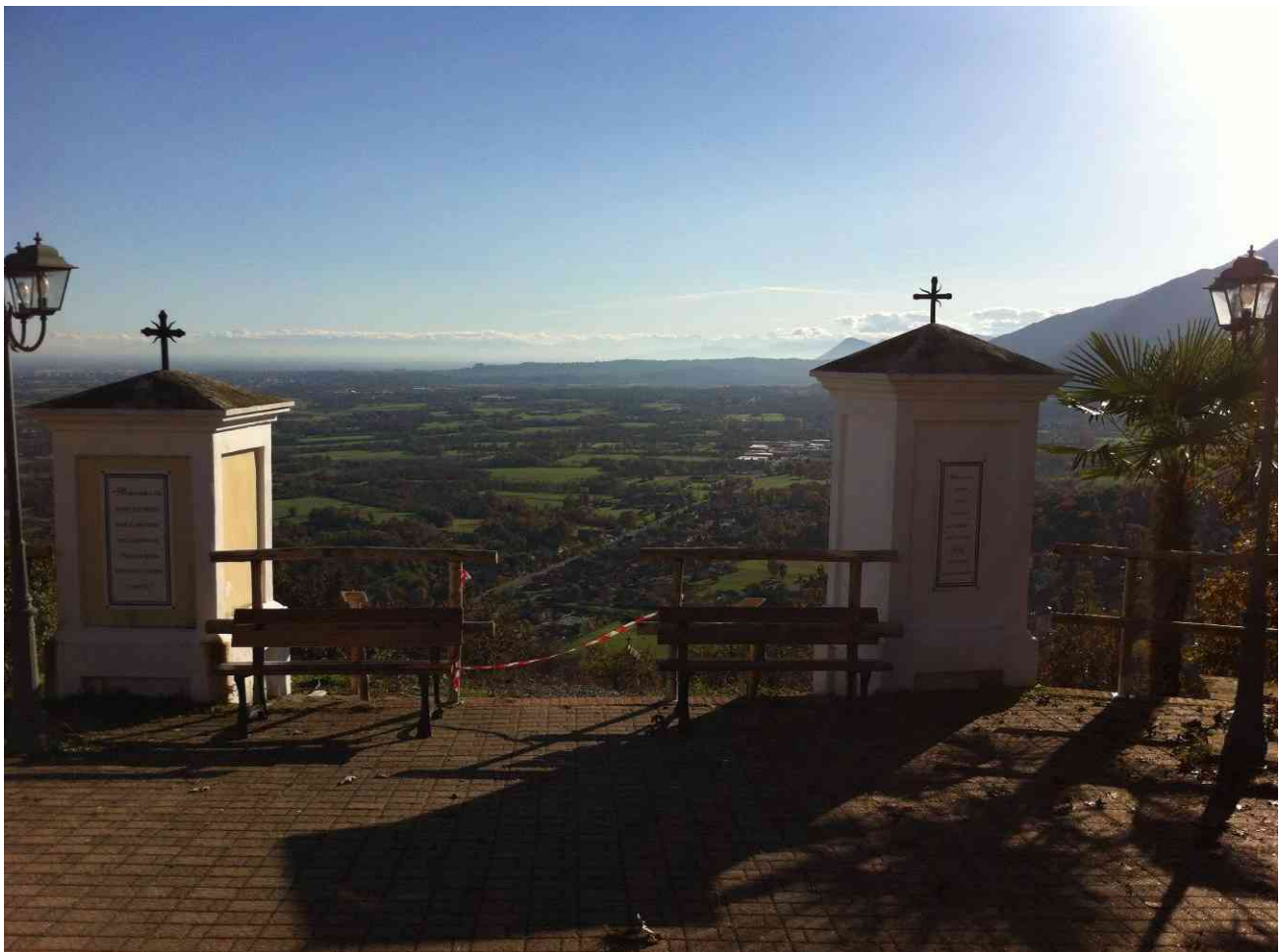
Piazzale Santuario Santa Maria – Piloni stazione 13 e 14 – Dopo i lavori
