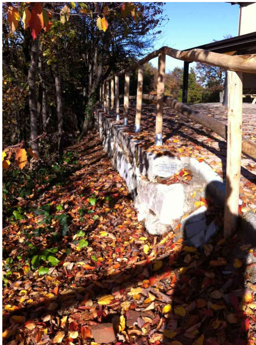
Lavori eseguiti - Muretto e staccionata sostegno strada di accesso
