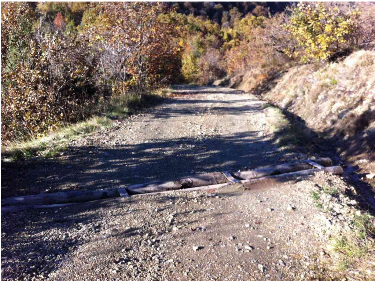
Lavori eseguiti – Canalette strada carrozzabile di accesso
