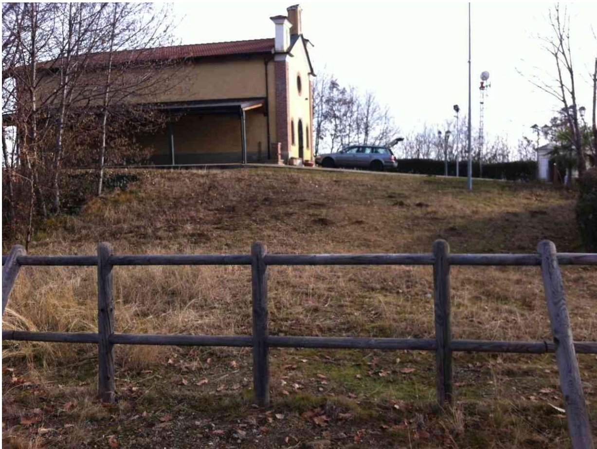
Piazzale Santuario Santa Maria – Vista verso la cappella – Prima dei lavori
