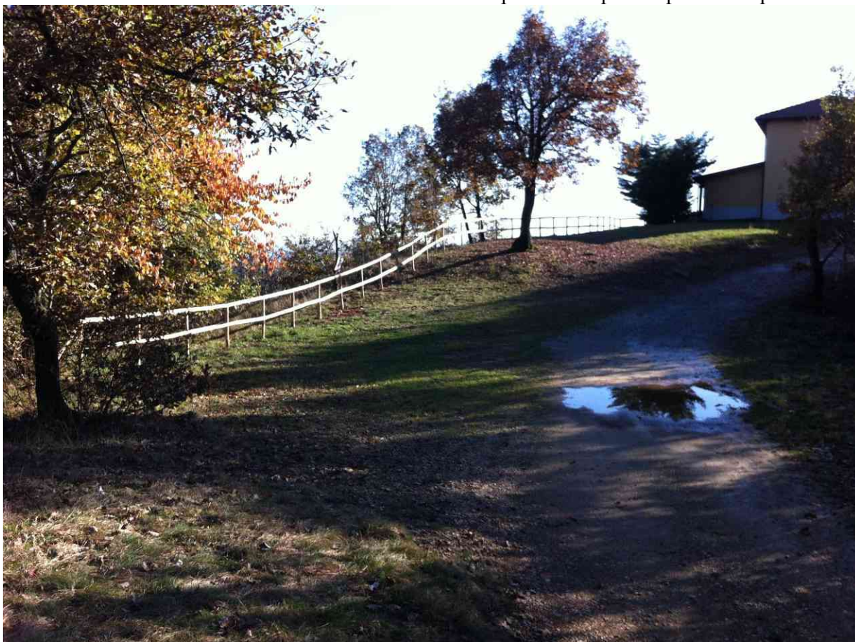
Vista Santuario di S. Maria Ausiliatrice – staccionata a protezione parti esposte - Dopo i lavori
