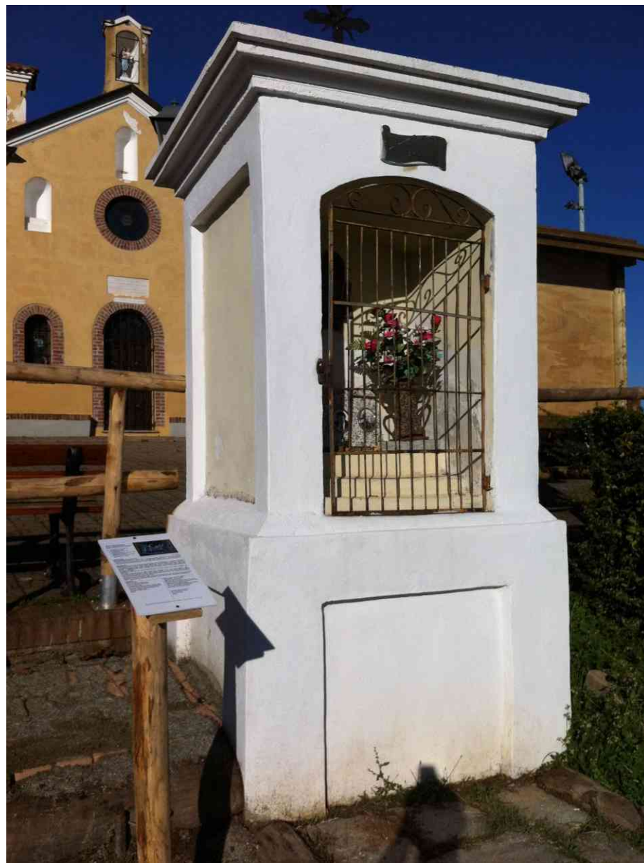
Via Crucis – Pilone stazione 14 – Dopo i lavori
