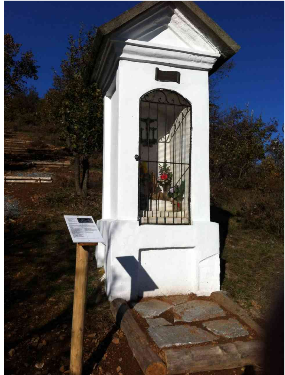
Via Crucis – Pilone stazione 11 – Dopo i lavori
