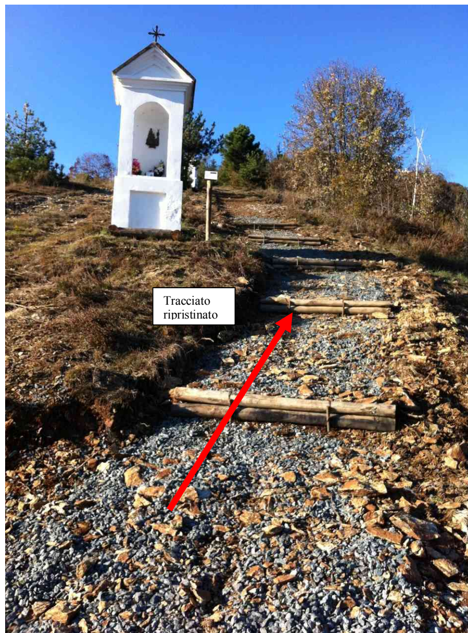
Via Crucis – Partenza dopo ponticello Dopo i lavori
