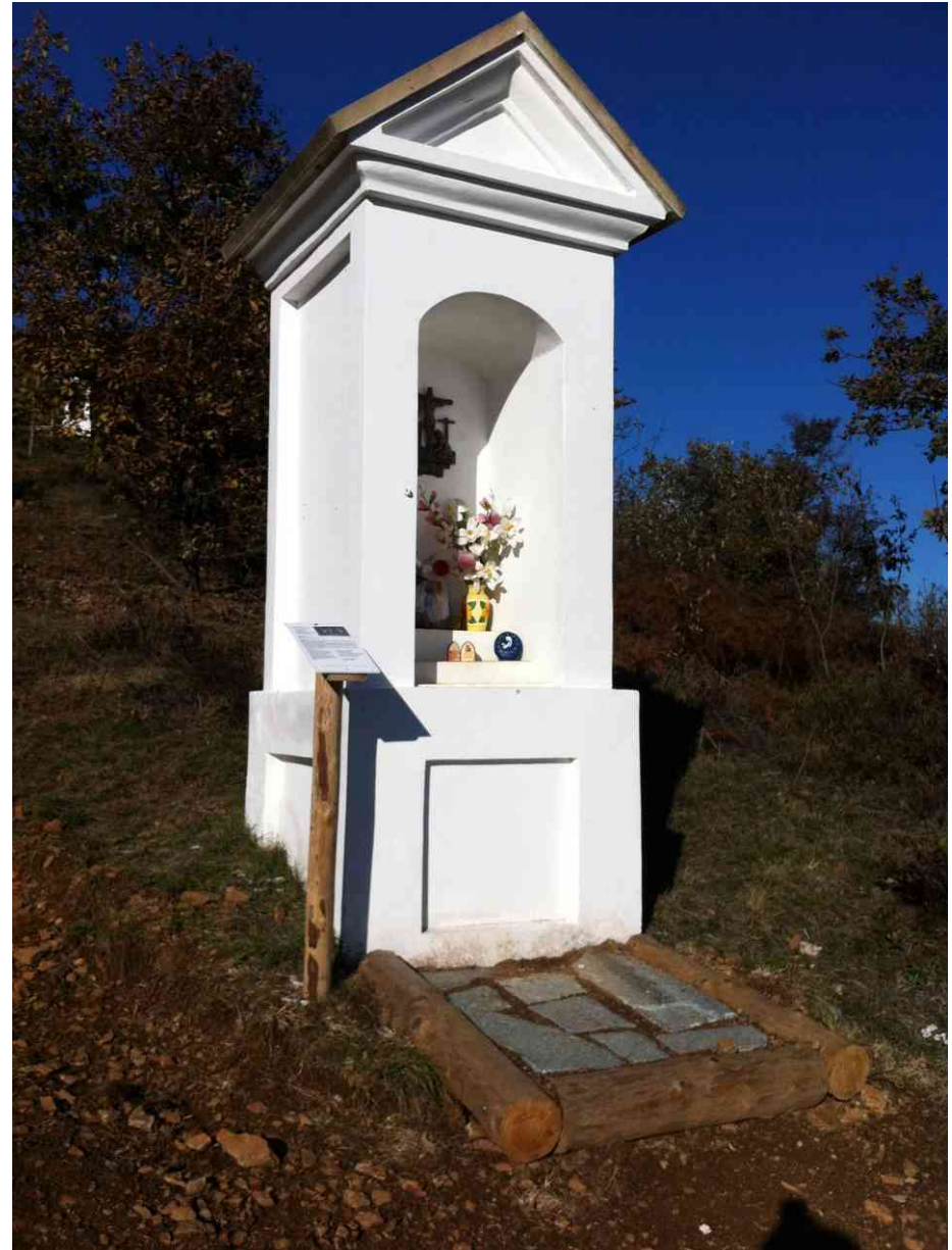
Via Crucis – Pilone stazione 10 – Dopo i lavori
