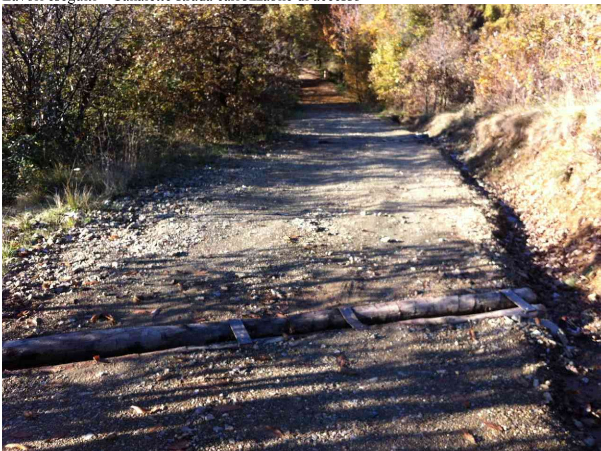
Lavori eseguiti – Canalette strada carrozzabile di accesso
