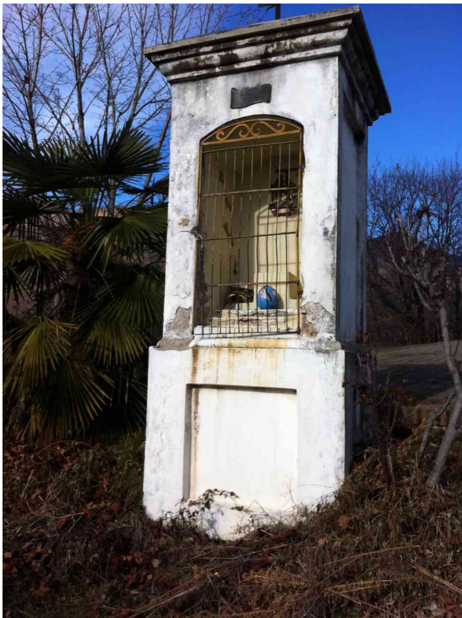
Via Crucis – Pilone stazione 13 – Prima dei lavori
