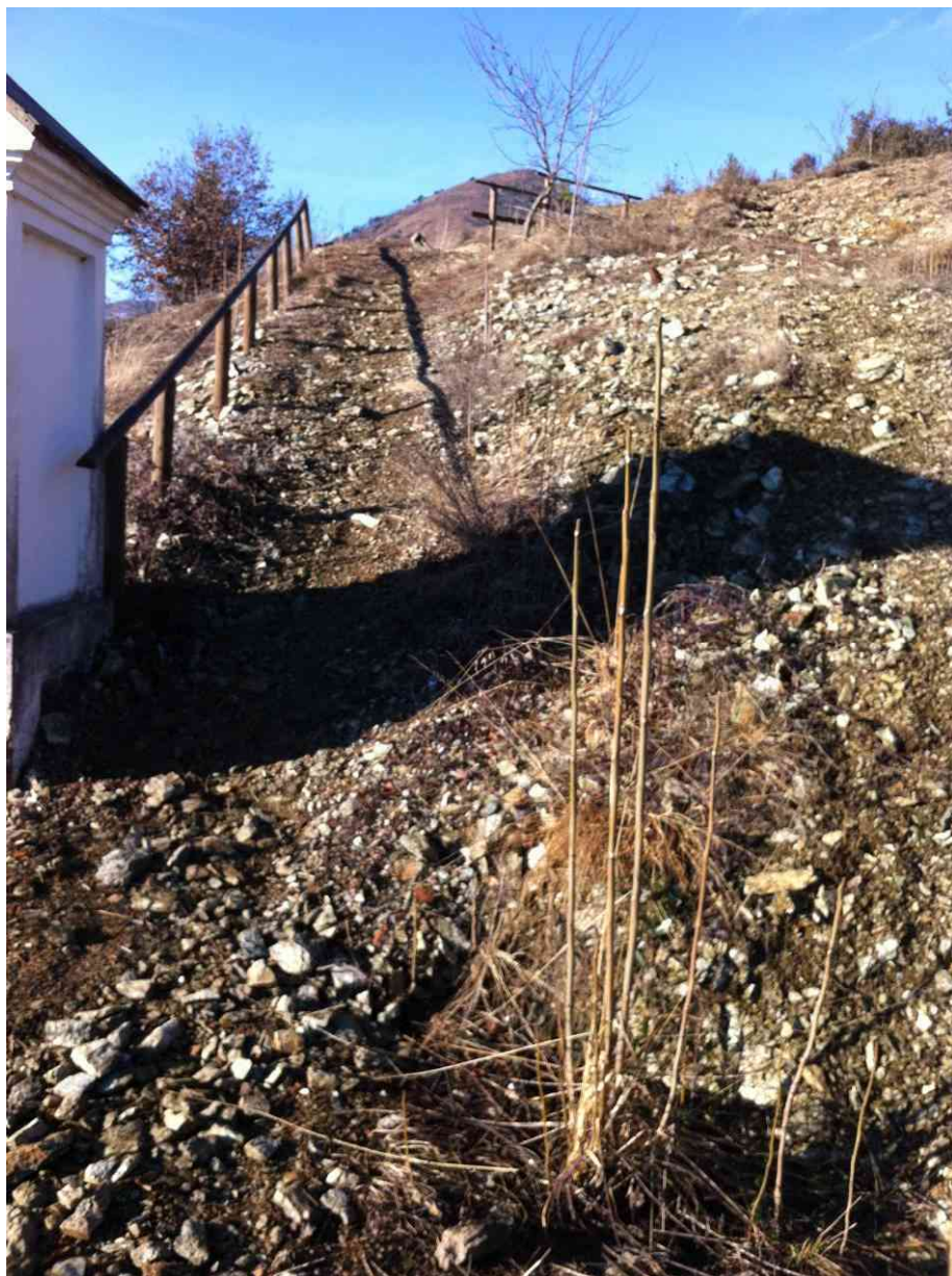
Partenza Via Crucis – da Pilone 1 - Prima dei lavori
