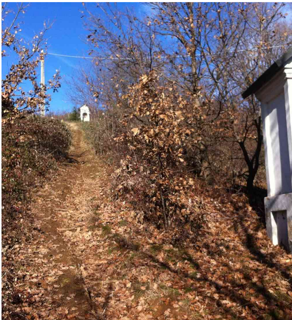
Via Crucis – Pilone stazione 6 e 7 in fondo - Prima dei lavori
