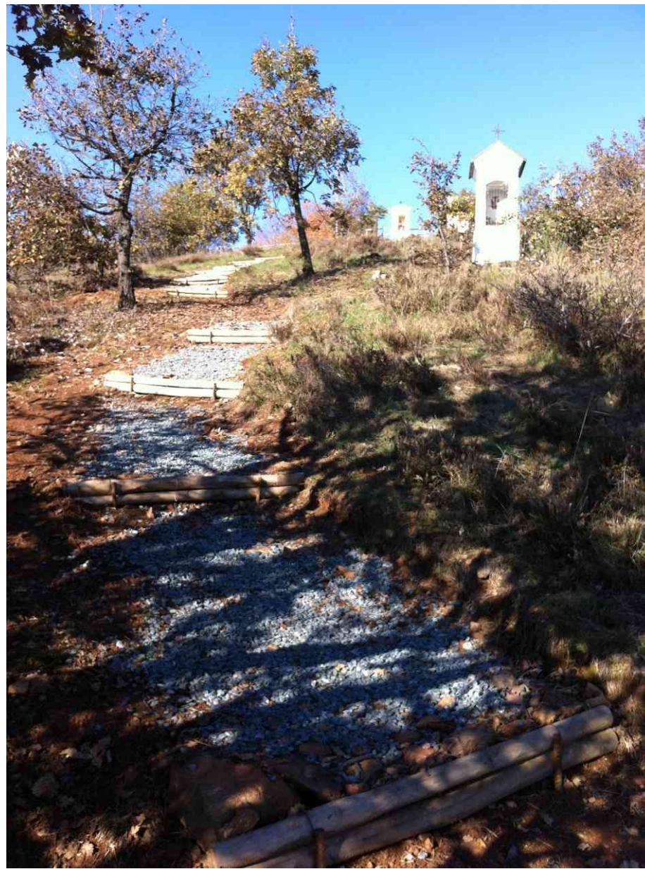
Via Crucis – Sentiero dopo Cappelletta – Dopo i lavori
