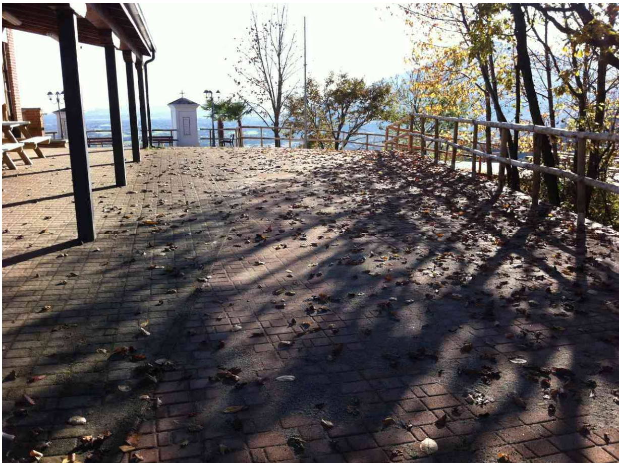
Accesso al piazzale Santuario Santa Maria – Dopo i lavori
