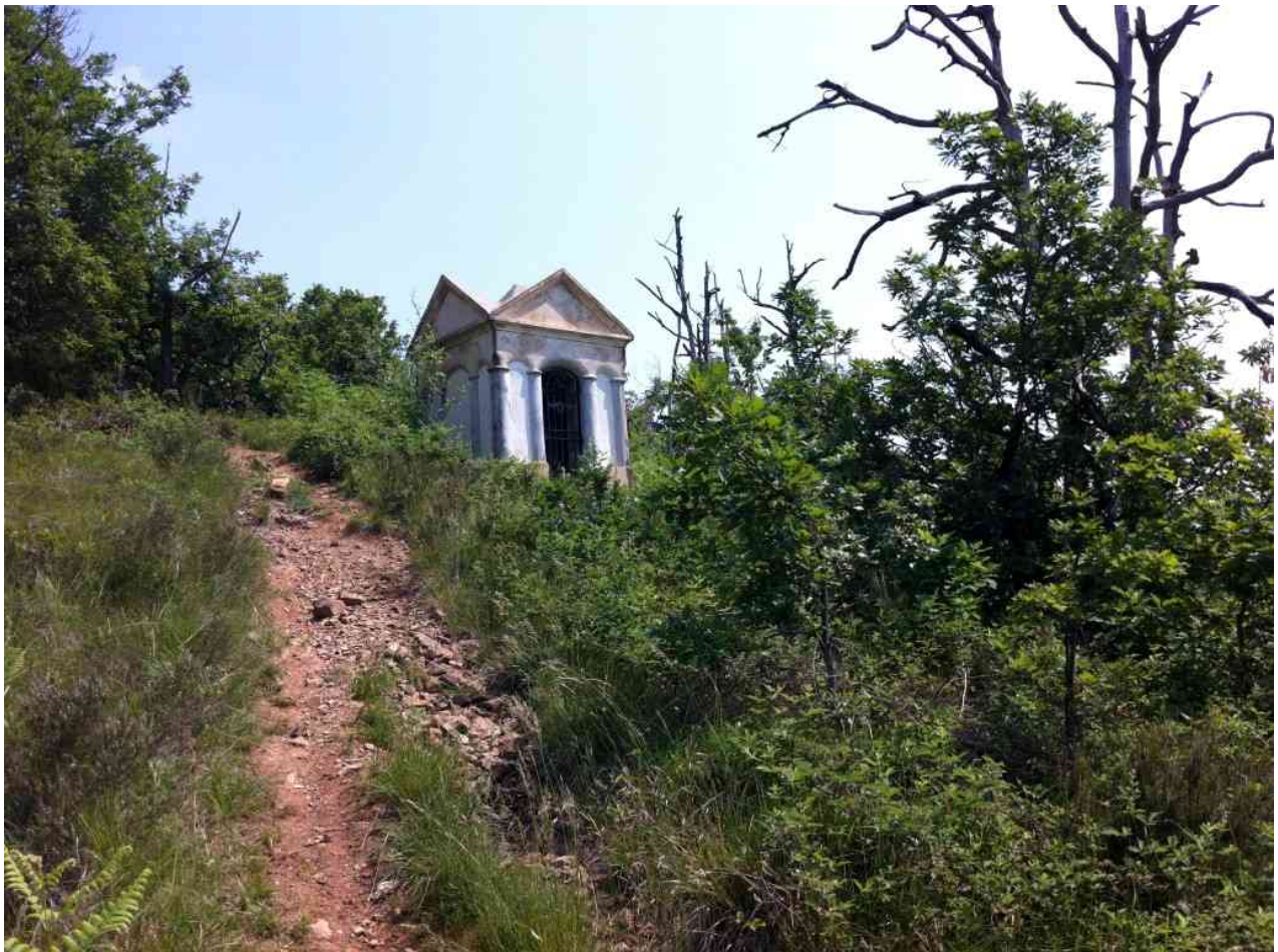
Via Crucis – Sentiero verso cappelletta – Prima dei lavori
