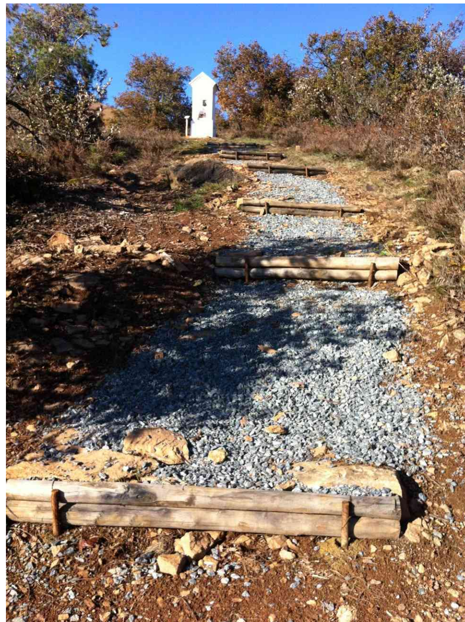
Via Crucis – Verso pilone stazione 10 a salire – Dopo i lavori
