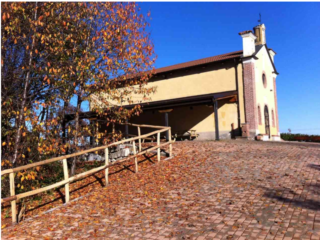
Piazzale Santuario Santa Maria – Vista verso la cappella – Dopo i lavori
