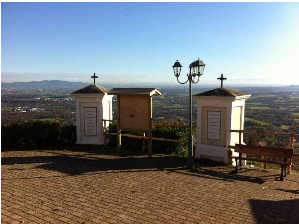
Piazzale Santuario Santa Maria – Vista verso valle – Dopo i lavori
