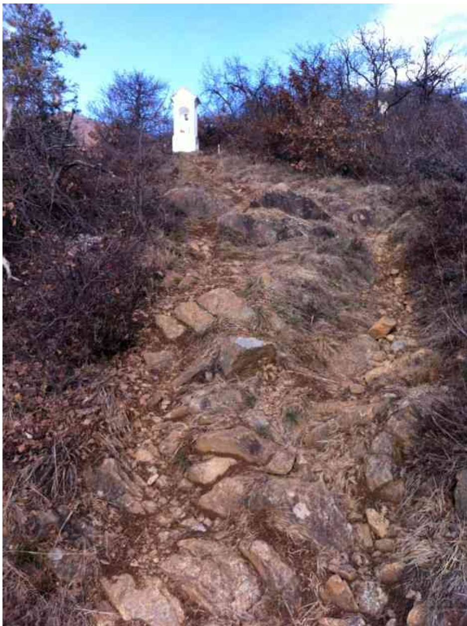
Via Crucis – Verso pilone stazione 10 a salire – Prima dei lavori
