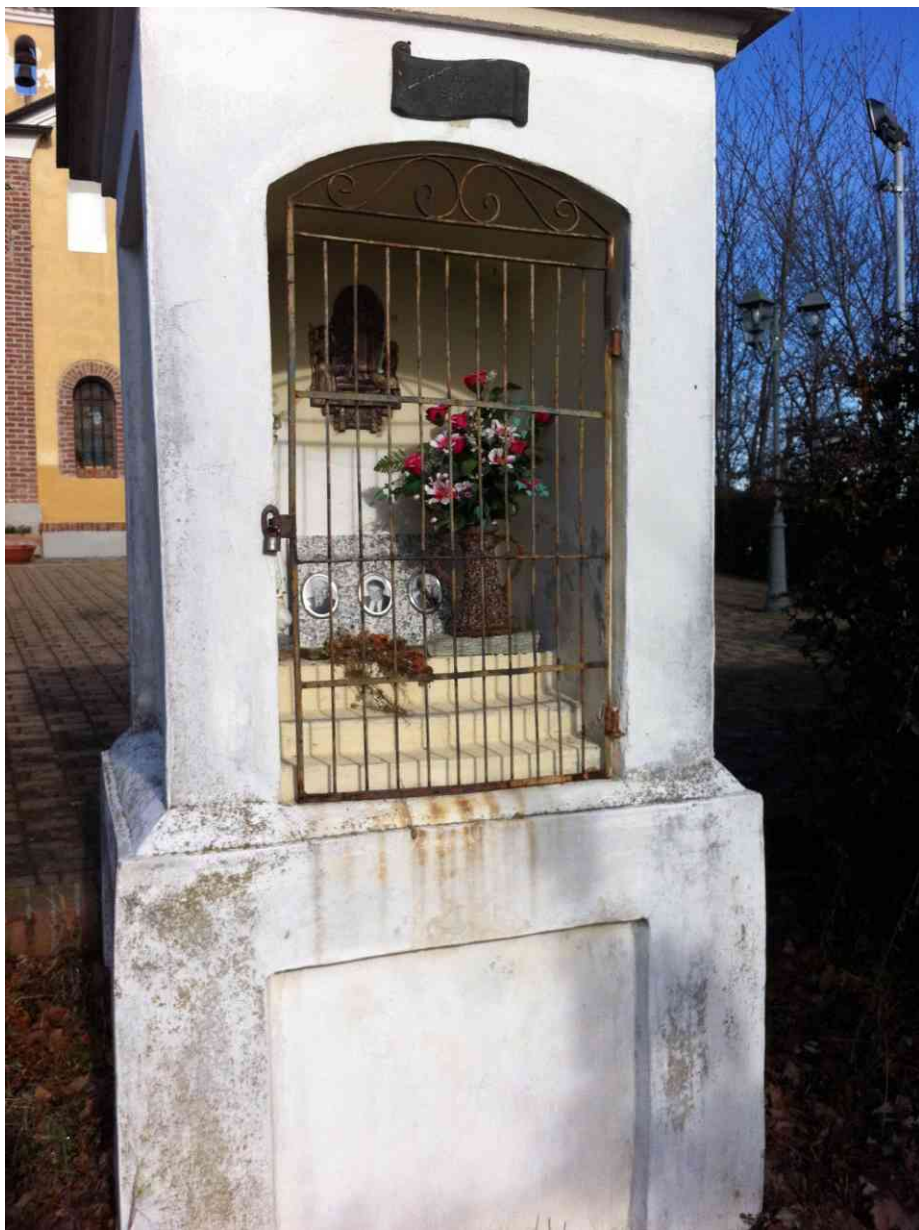
Via Crucis – Pilone stazione 14 – Prima dei lavori
