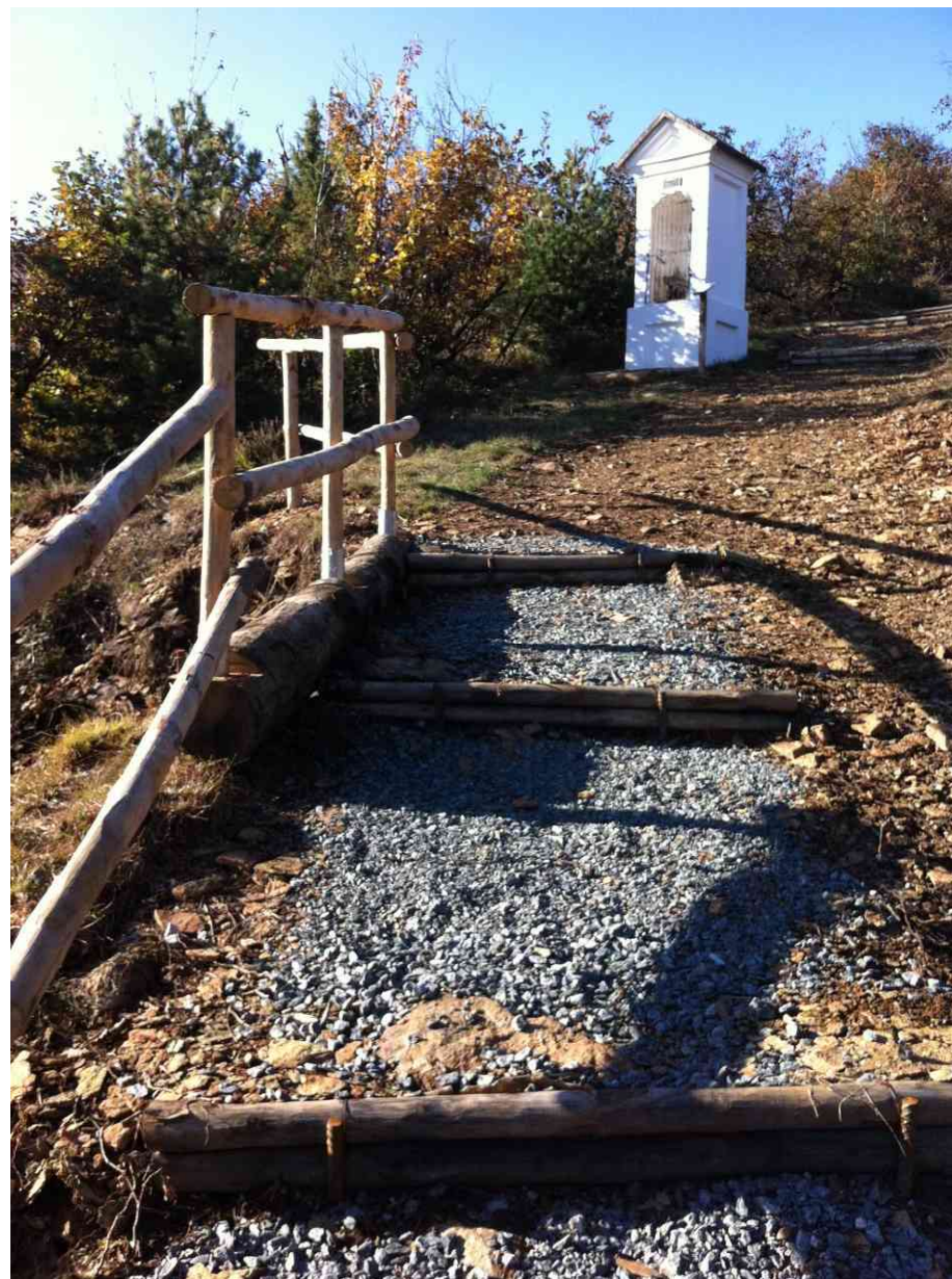
Via Crucis – Verso pilone stazione 8 a salire - Dopo i lavori
