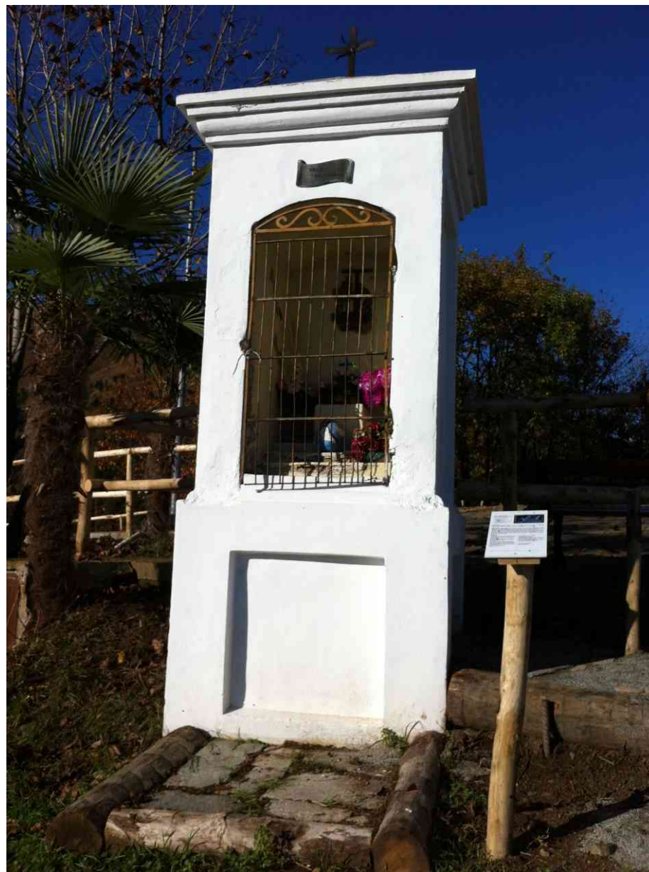
Via Crucis – Pilone stazione 13 – Dopo i lavori
