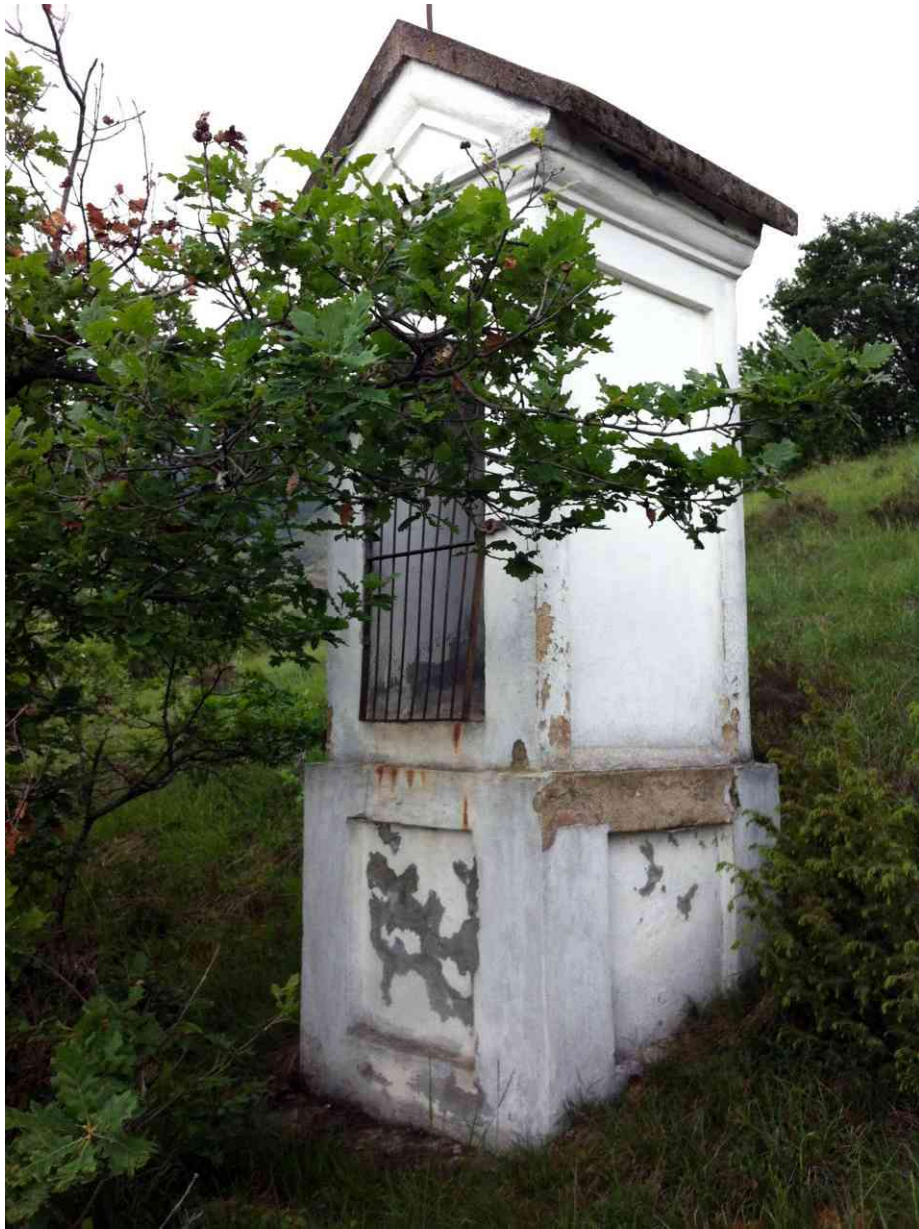
Via Crucis – Pilone stazione 12 – Prima dei lavori
