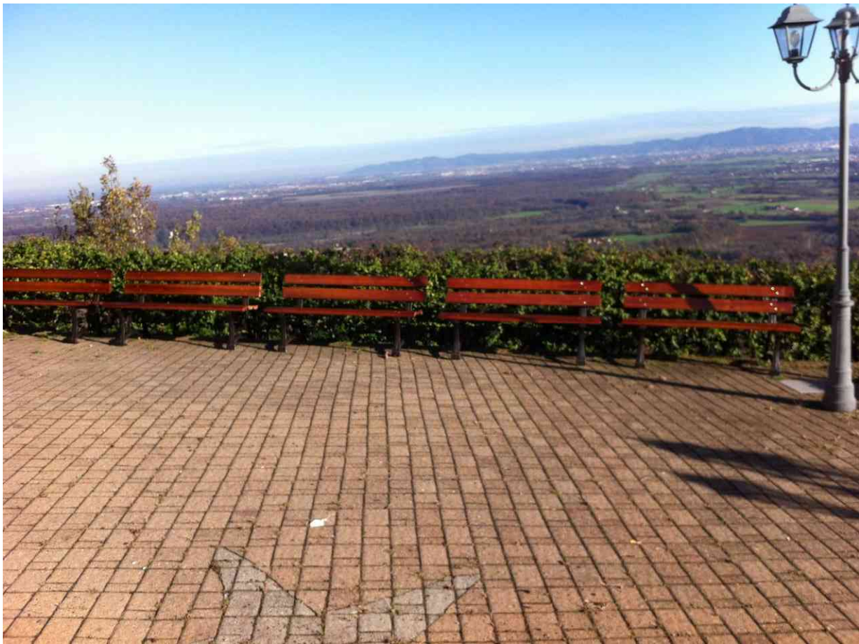
Lavori eseguiti – Panchine su piazzale
