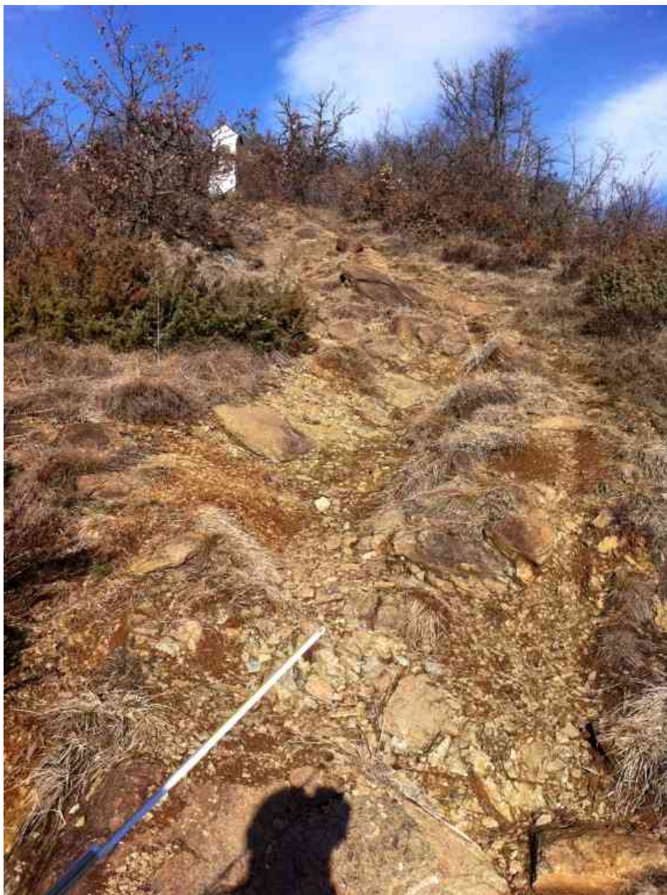
Via Crucis – Verso pilone stazione 9 a salire – Prima dei lavori
