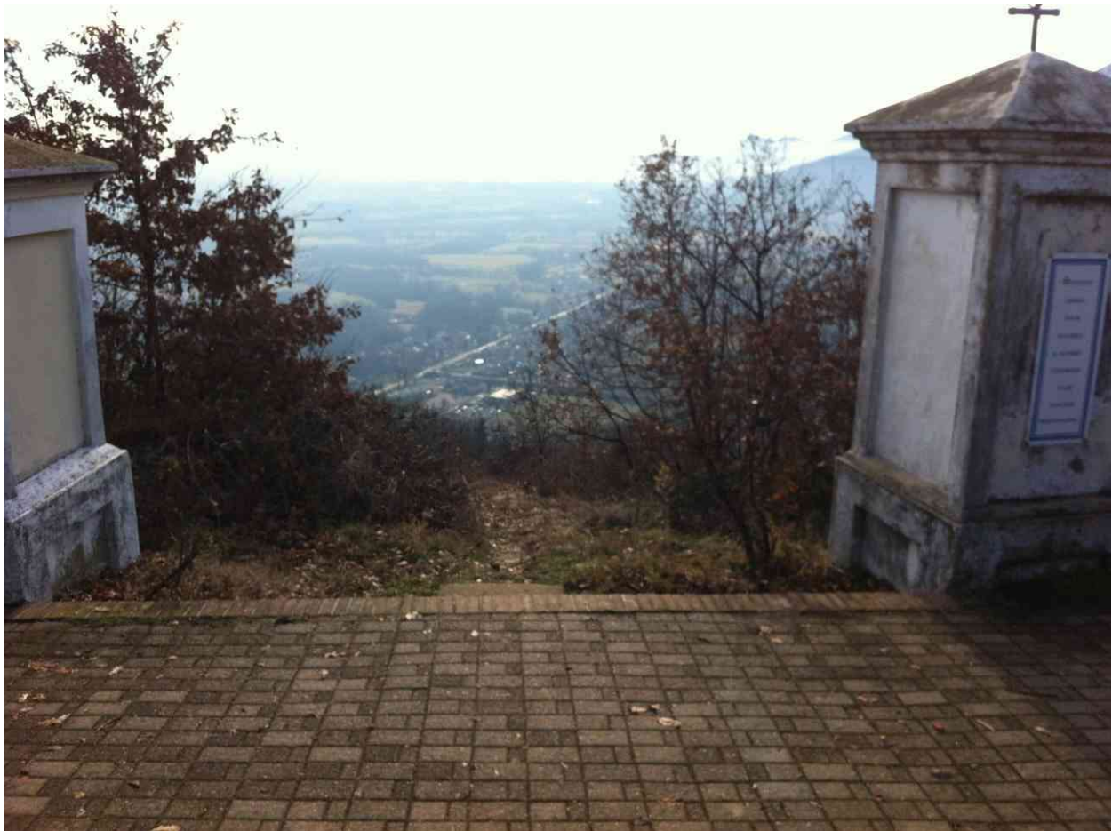
Piazzale Santuario Santa Maria – Piloni stazione 13 e 14 – Prima dei lavori
