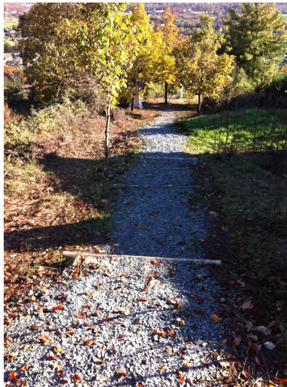
Via Crucis – Da pilone stazione 7 a scendere – Dopo i lavori
