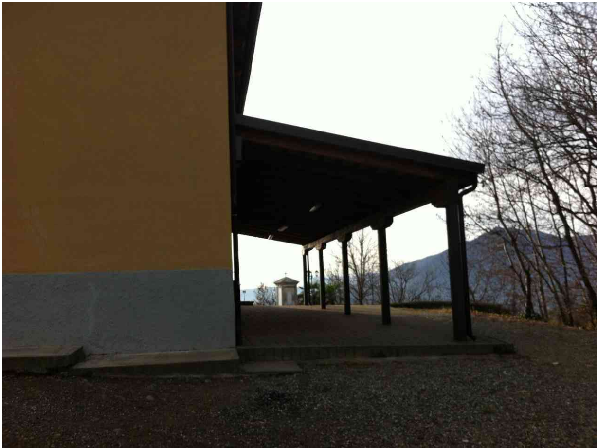
Accesso al piazzale Santuario Santa Maria – Prima dei lavori
