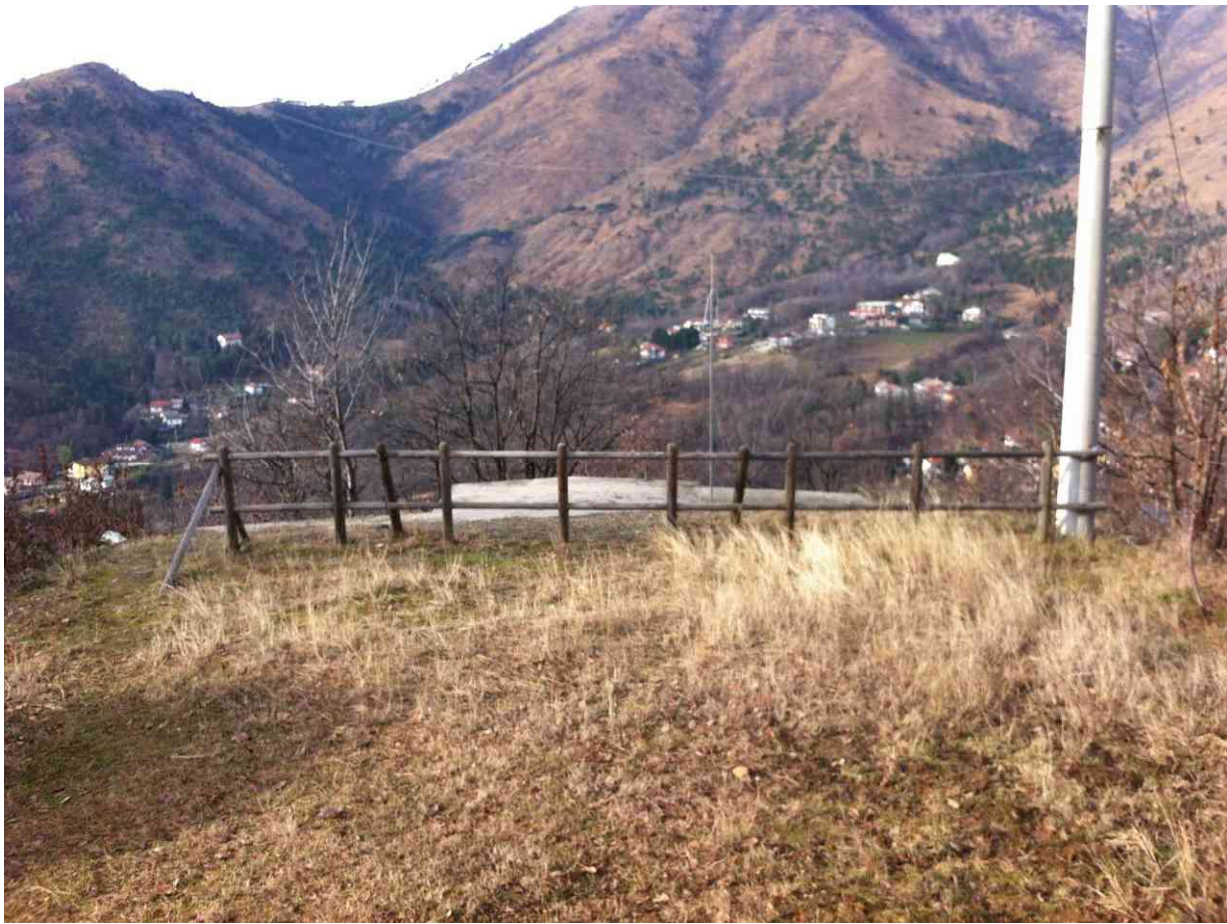
Piazzale Santuario Santa Maria – Vista verso Givoletto – Prima dei lavori
