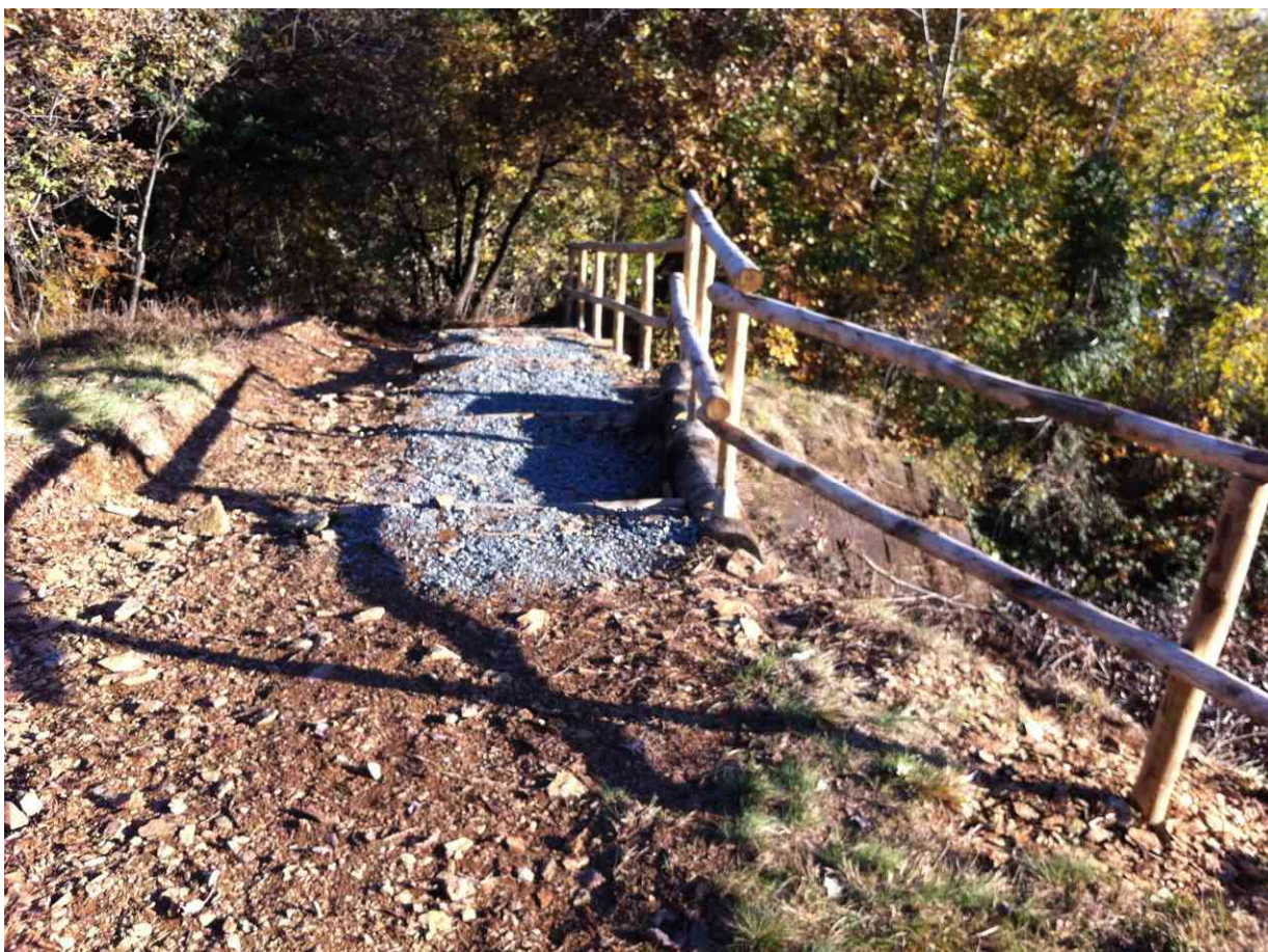
Via Crucis – Da pilone stazione 8 su tornante strada a scendere – Dopo i lavori
