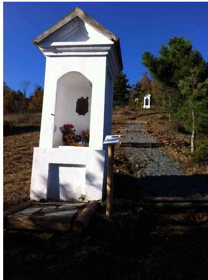
Via Crucis – Sentiero pilone stazione 4 - Dopo i lavori
