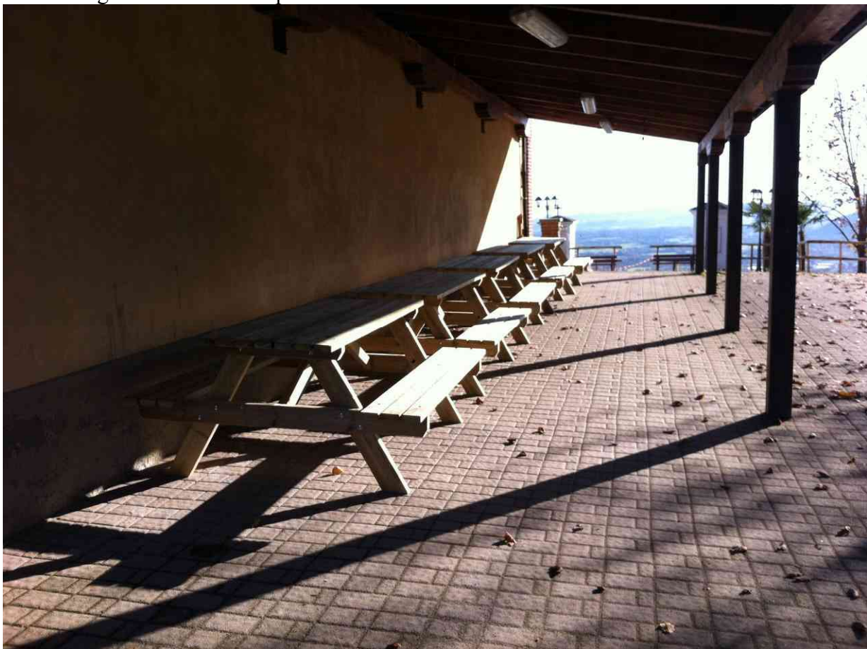
Lavori eseguiti – Tavoli pic nic sotto tettoia
