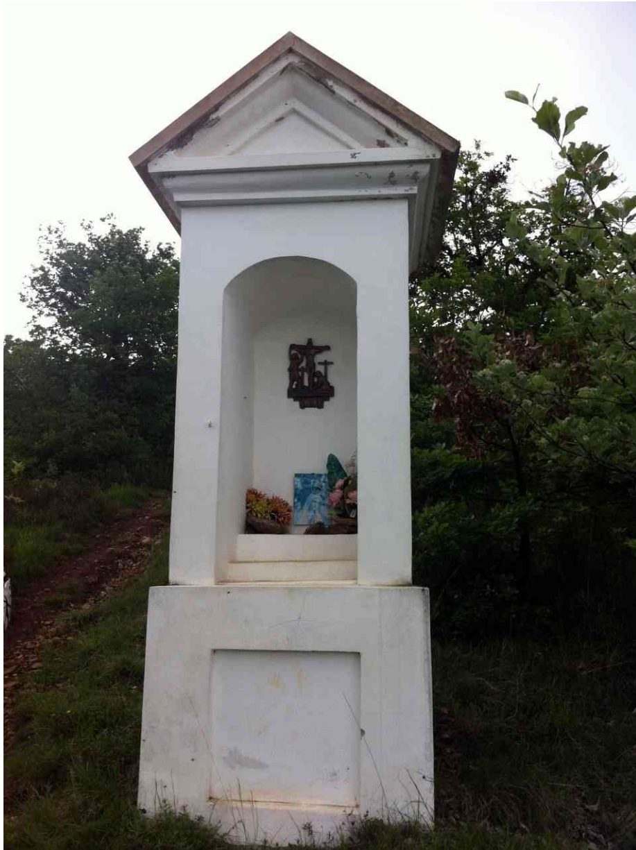
Via Crucis – Pilone stazione 10 – Prima dei lavori
