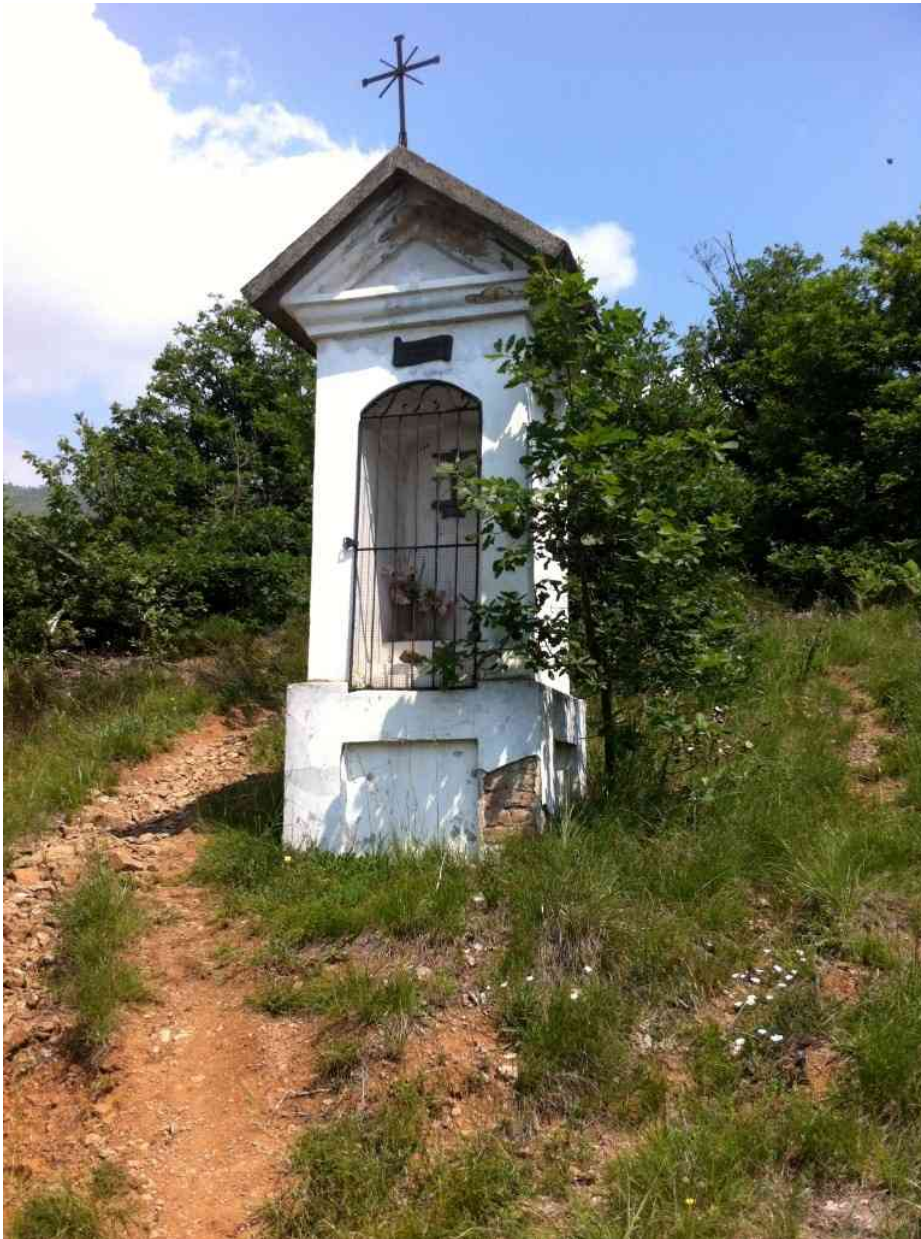
Via Crucis – Pilone stazione 11 – Prima dei lavori
