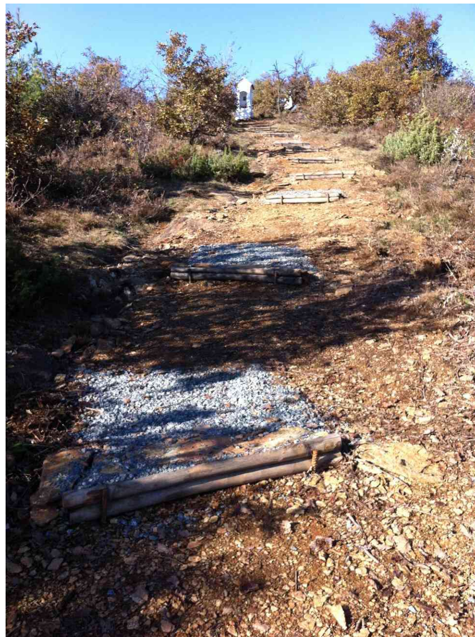
Via Crucis – Verso pilone stazione 9 a salire – Dopo i lavori
