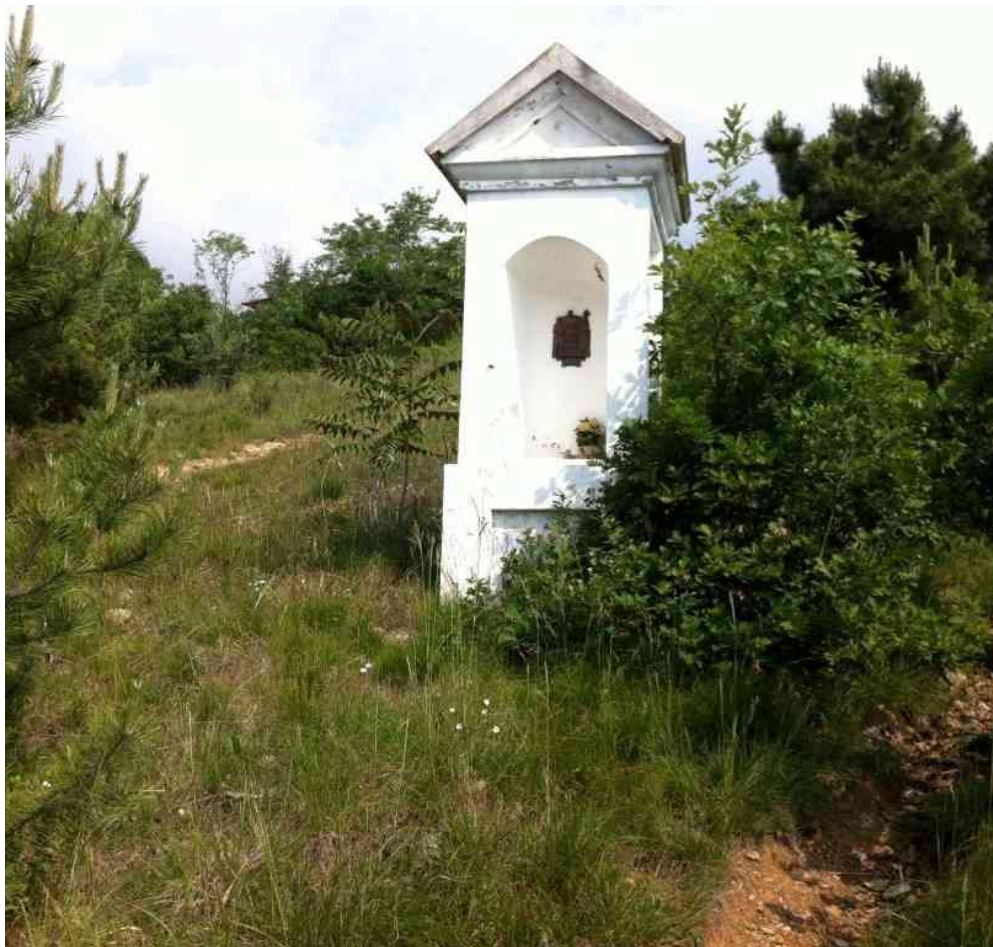
Via Crucis – Sentiero pilone stazione 4 - Prima dei lavori
